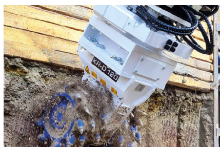
KRD 120 | Perfilado de muros pantalla
