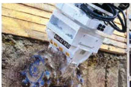
KRD 120 | Perfilado de muros pantalla
