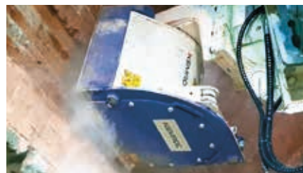
EX 45 HD | Saneamiento de túnel
