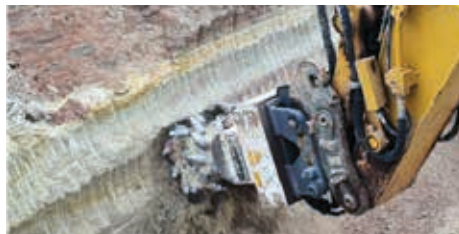
KR 80 | Preparación de cimientos
