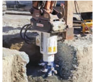
KRX 30 | Fresado de pilotes
