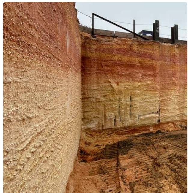
Apuntalamiento de zanjas con una cortadora mezcladora KSI
