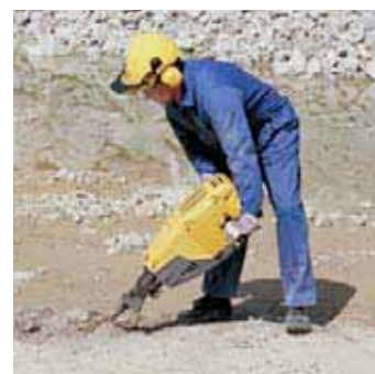
Apertura de zanjas
