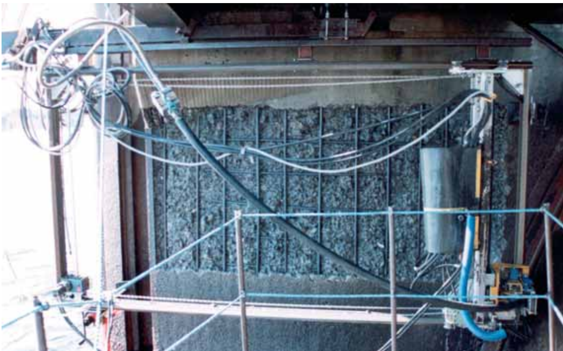
Reparación de pilares
