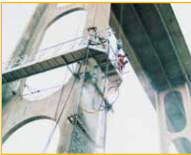
Jetframe 102 trabajando en un puente
