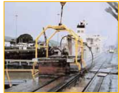
Hidrodemolición de un dique con Jetframe 122
