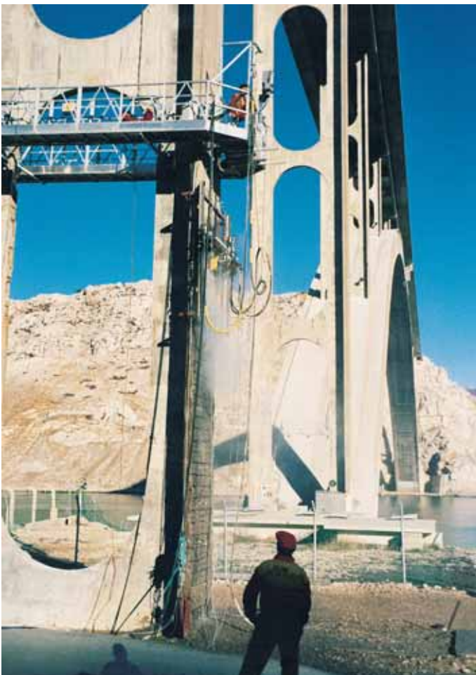
Hidrodemolición con Jetframe en puentes
