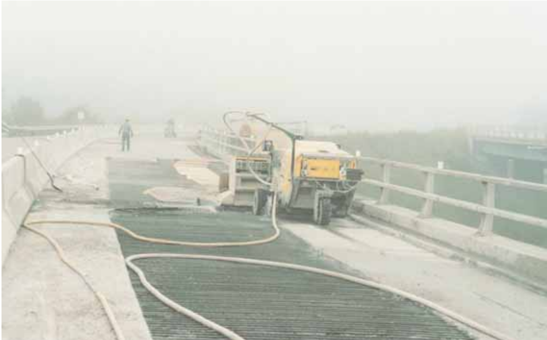
Hidrodemolición en tableros de puentes
