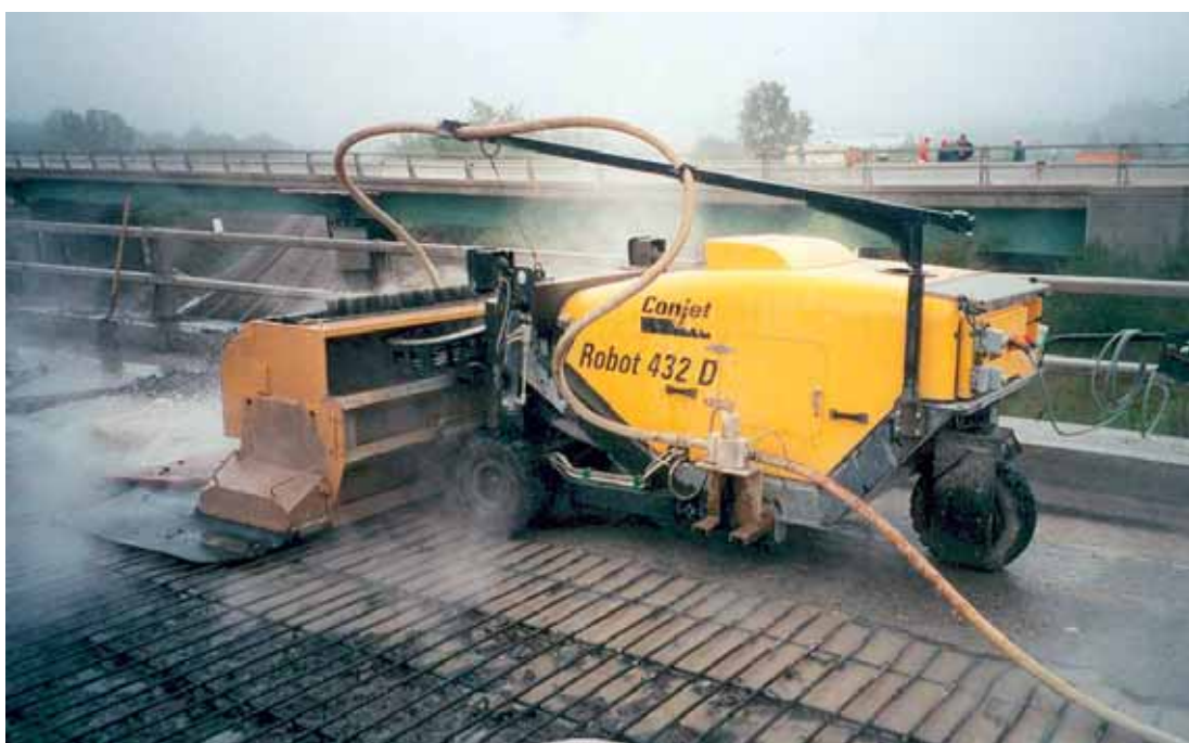
Trabajos de gran envergadura
