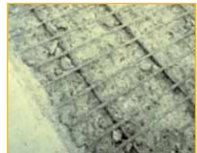
Resultados de la hidrodemolición
