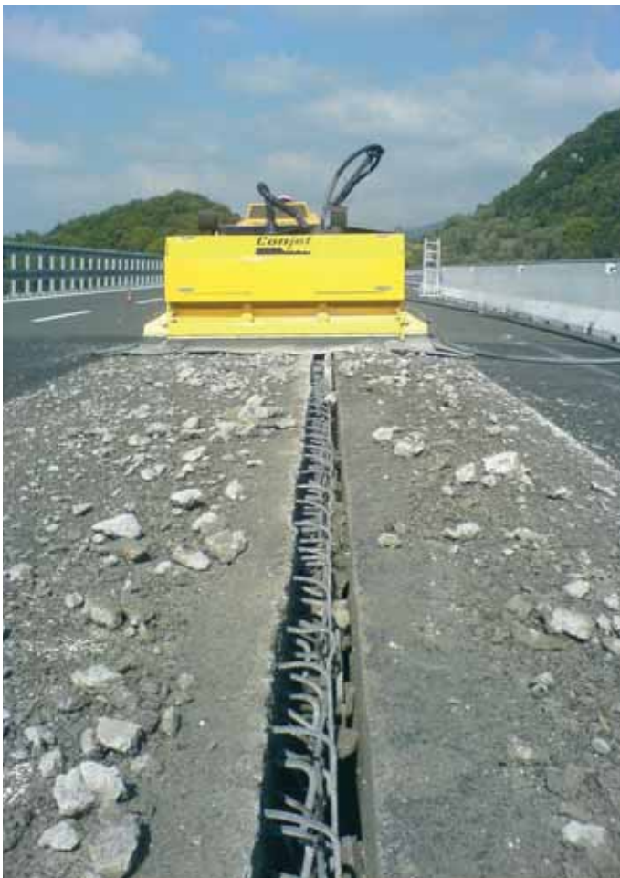
Reparación de juntas de puentes
