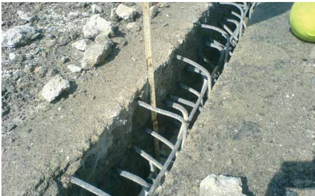
Retirada del hormigón en zonas muy definidas
