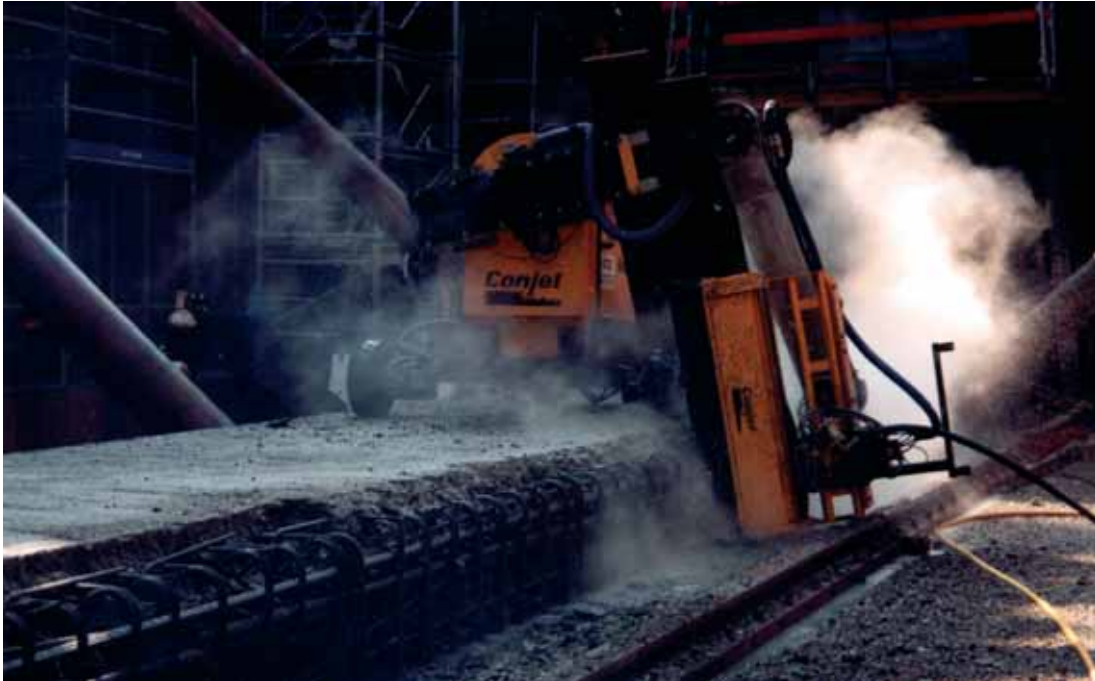
Extracción de hormigón en superficies irregulares
