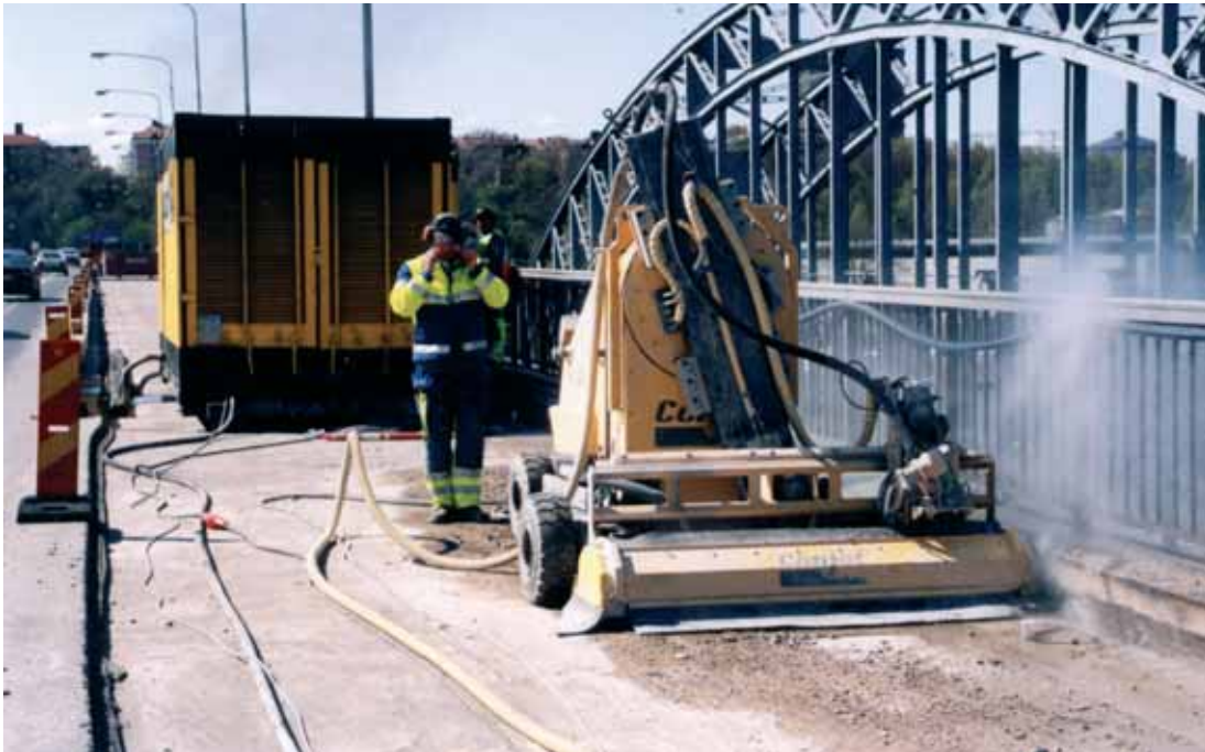
Hidrodemolición en tableros de puentes
