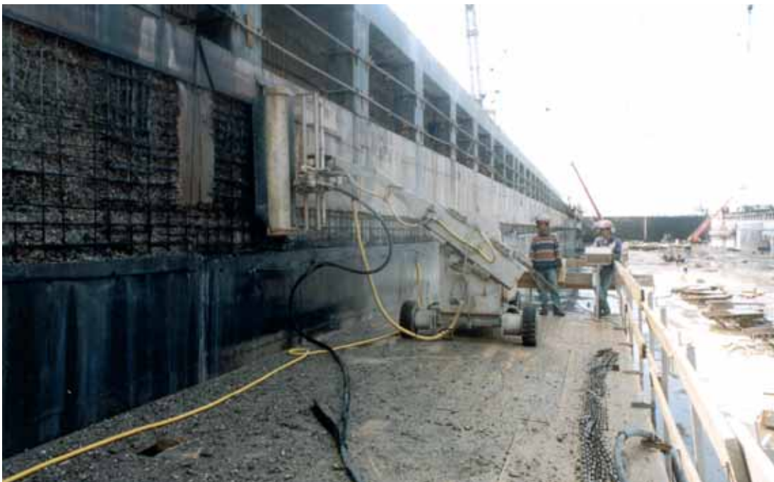
Reparación de diques
