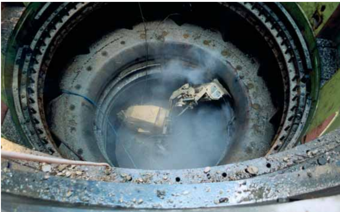
Eliminación de hormigón en una turbina
