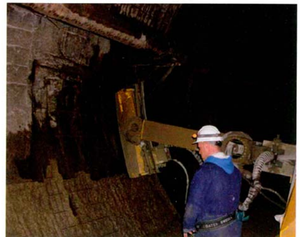
El diseño de los robots Conjet, que se adapta a superficies curvas, permite trabajar en túneles y galerías con comodidad y precisión.
