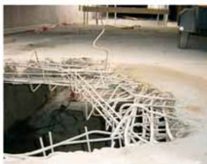
Resultados de la demolición con martillos
