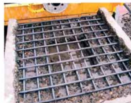
Resultados de la hidrodemolición
