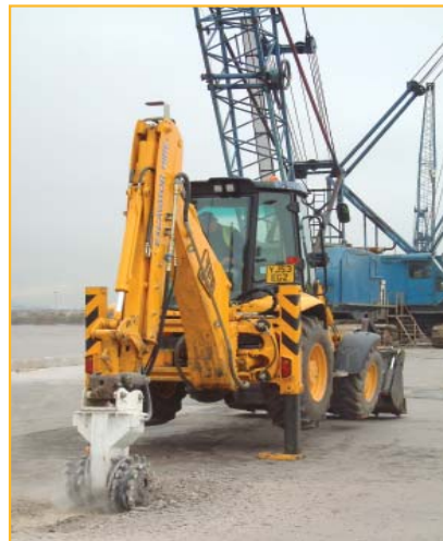
Preparación de hormigón
