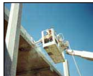
Perforadora 210B modificada para una plataforma de elevación
