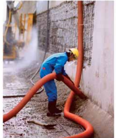
Limpeza de las superficies después de la hidrodemolición
