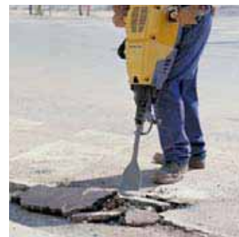
Cortar asfalto
