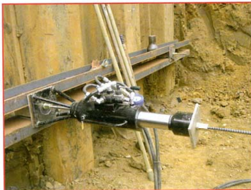
Instalación del anclaje
