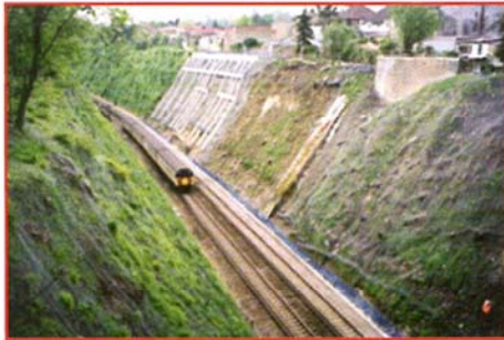
Estabilización de taludes en la línea ferroviaria Londres-Brighton
